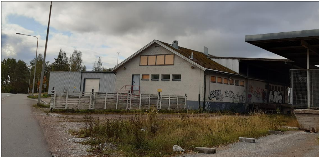
Purettava rakennus Kivenkadun ja Teollisuuskadun kulmauksessa.
