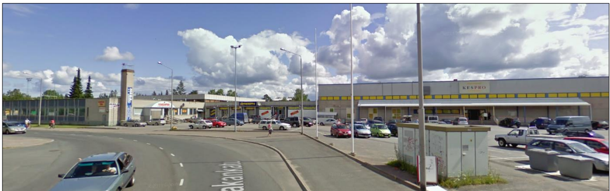
Korttelin 20 tontin 18 purettavat rakennukset kesällä 2009 © Google Street View.
